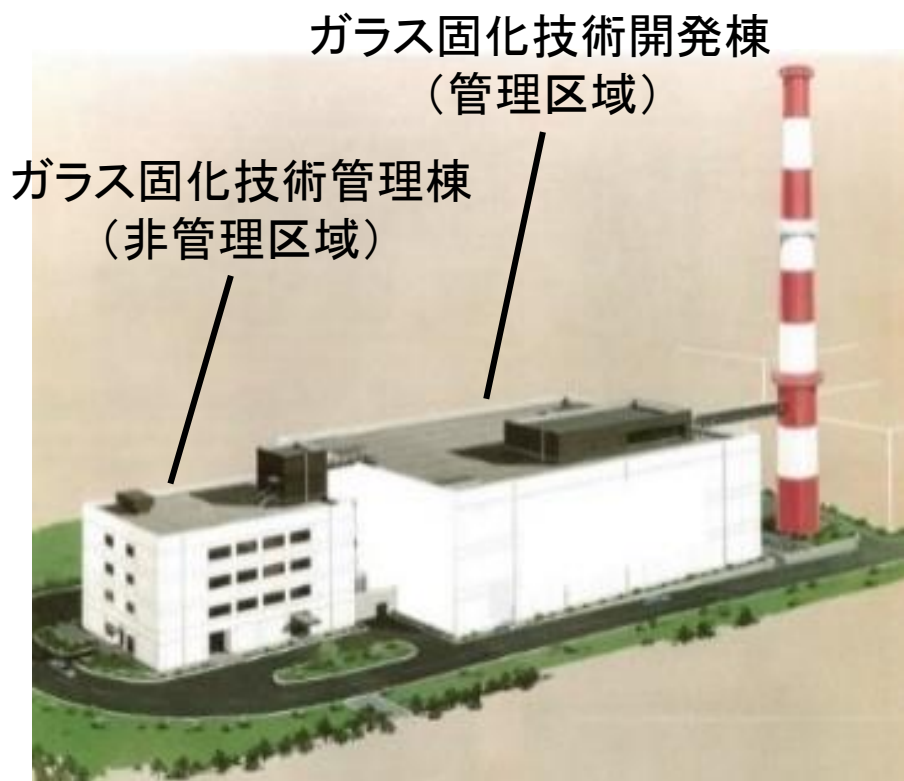
ガラス固化技術開発施設(TVF※)の外観
