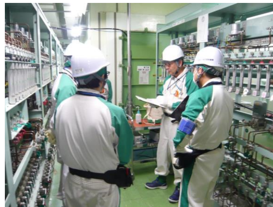
計装用導圧管の詰まり点検・除去作業後における観察者によるコーチング
